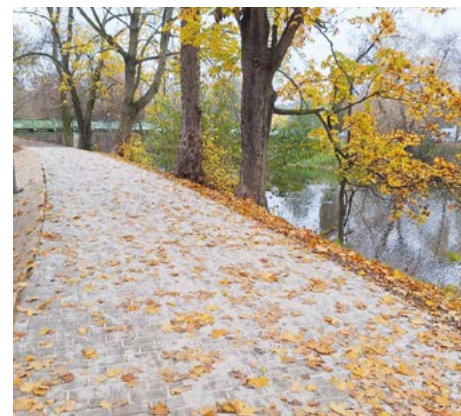
Svatka, pravobřežní komunikace, dlažba
